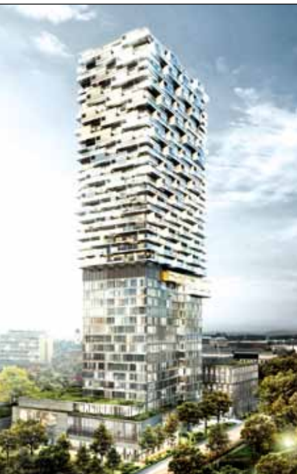
In zentrumsnaher Lage entsteht bis 2020 auf dem Kulturcampus Frankfurt der Hybridturm One Forty West
